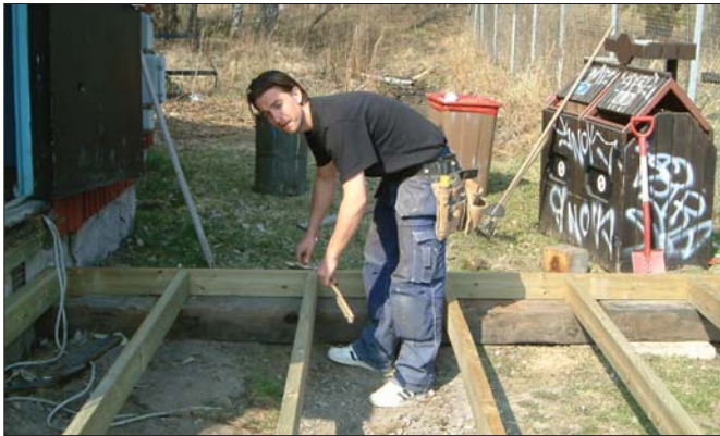
Mange Carlsson kollar om synvinkeln verkligen är 90 grader. Mange tänkte och spikade så det sjöng om det. Efter 8 timmars jobb var så terrassen klar.
